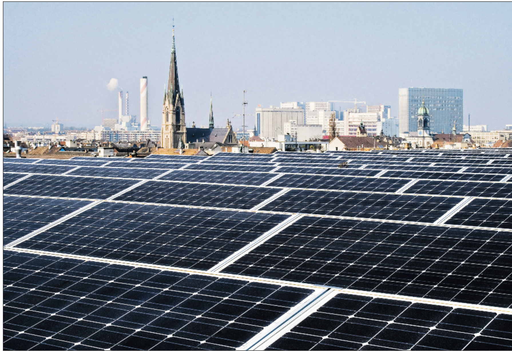
Haben negative Auswirkungen auf das Stadtbild: Anhäufung von Fotovoltaikanlagen auf den Dächern der Stadt Basel.
